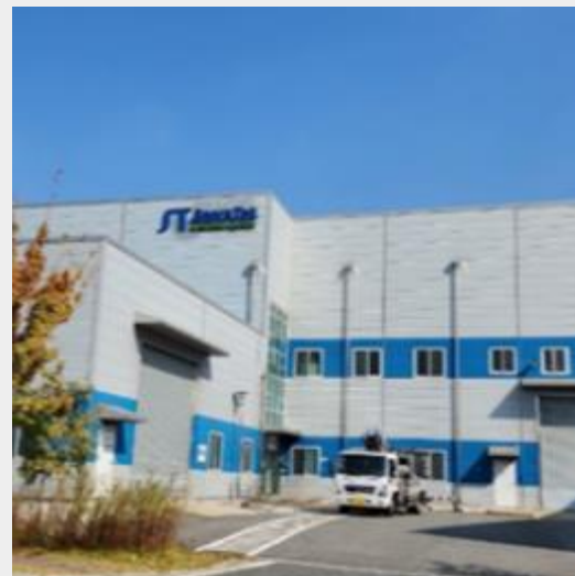
제 2공장 전경
